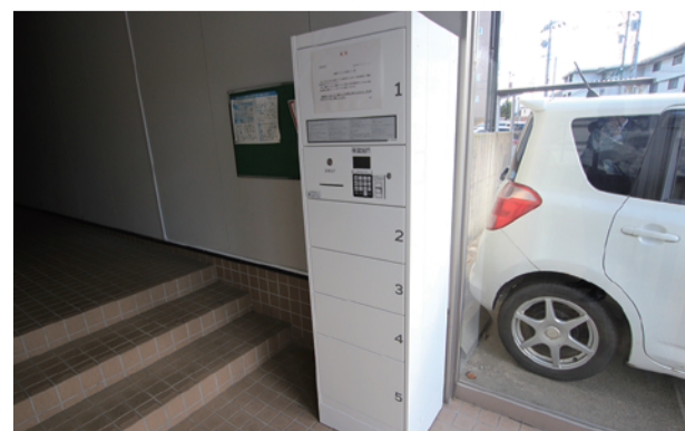
近年ニーズが高まっている宅配ボックス。多くの賃貸物件に設置した。
